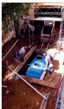
Instal·lació del dipòsit de recollida d'aigües de 6.000 litres al pati
