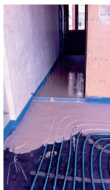
Formigonat del terra radiant amb anhidrita
